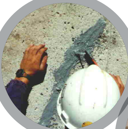
Stabilisation de fissures
