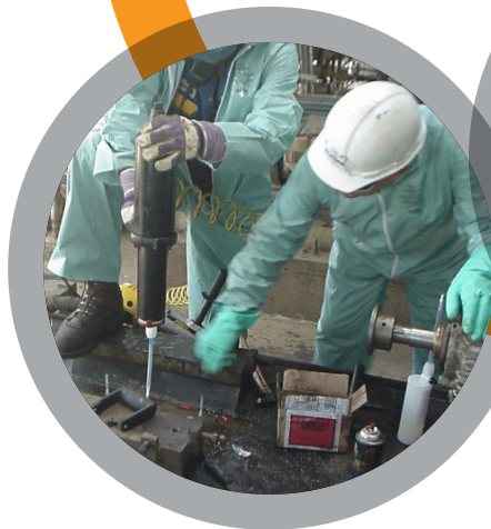
Scellement de plaques de support
