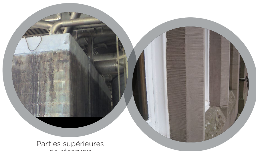
Réparation d'appuis de fenêtres
