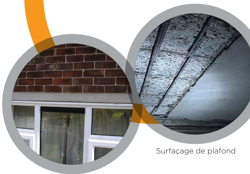
Réparation de linteaux
